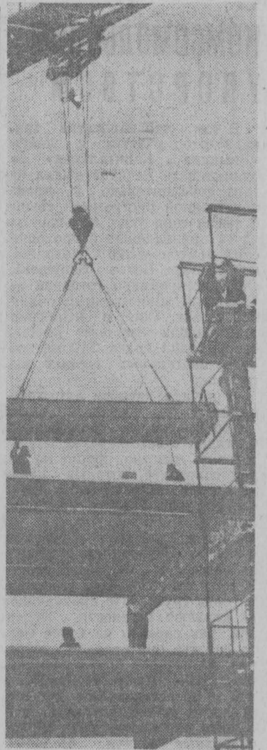
Через несколько лет шахта «Зенковская - Капитальная» будет одной из самых мощных в Кузнецком бассейне. В прошлом году здесь был поставлен копер над вспомогательным стволом. Сегодня рядом с ним из железобетонных блоков монтируется административно-бытовой комбинат шахты. Монтаж ведет бригада В. Н. Петрова из Зенковского шахтостроительного управления. НА СНИМКЕ: идет монтаж. Фото Ю. СЕРГЕЕВА.
