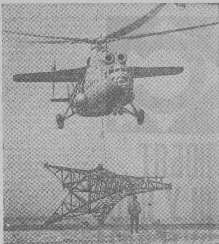
ТУРКМЕНСКАЯ ССР. На строительстве линии электропередачи, связывающей город Керки с поселком Головное, выросшим у истоков Каракумского канала имени В. И. Ленина, одержана трудовая победа — закончена транспортировка электроопор на протяжении стокилометровой трассы. Впервые для доставки пятитонных ажурных опор применялся вертолет «Ми-6». Авиаторы в несколько раз сократили сроки строительства. Скоро по новой электролинии пойдет ток единой энергосистемы Средней Азии.
