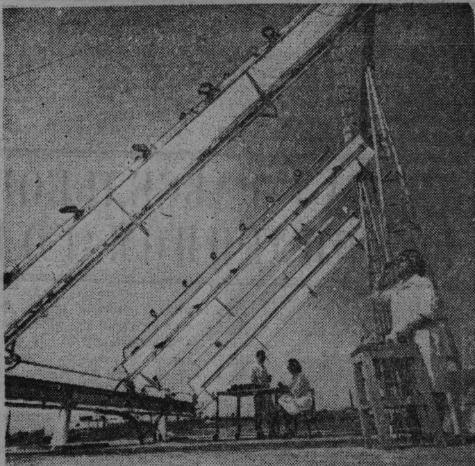
АРМЕНИЯ. На высоту 8-этажного дома 30 кубометров воды в сутки может подавать созданная советскими учеными солнечная энергетическая установка на фотопреобразователях. Она найдет широкое применение в южных районах страны. Установка проходит испытание в Ереванской базовой лаборатории Института источников тока.
