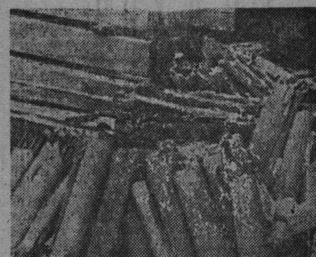
Хорошее нововведение сделали работники стройуправления № 2. Скорлупы для изоляции теплотрасс, изготовляемые в мехцехе, намного ускоряют и упрощают эту работу. Но чего будет строить эта изоляция после такого хранения скорлуп на стройке?
