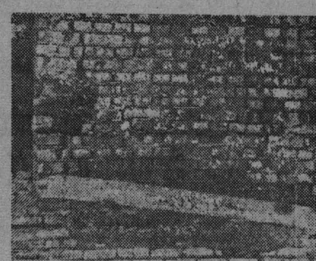
А вот и сама кладка в «расшивку», выполненная этим же коллективом на одном из корпусов новой городской больницы.
