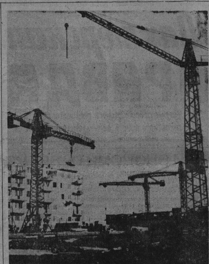
Строительство жилья в микрорайоне.
