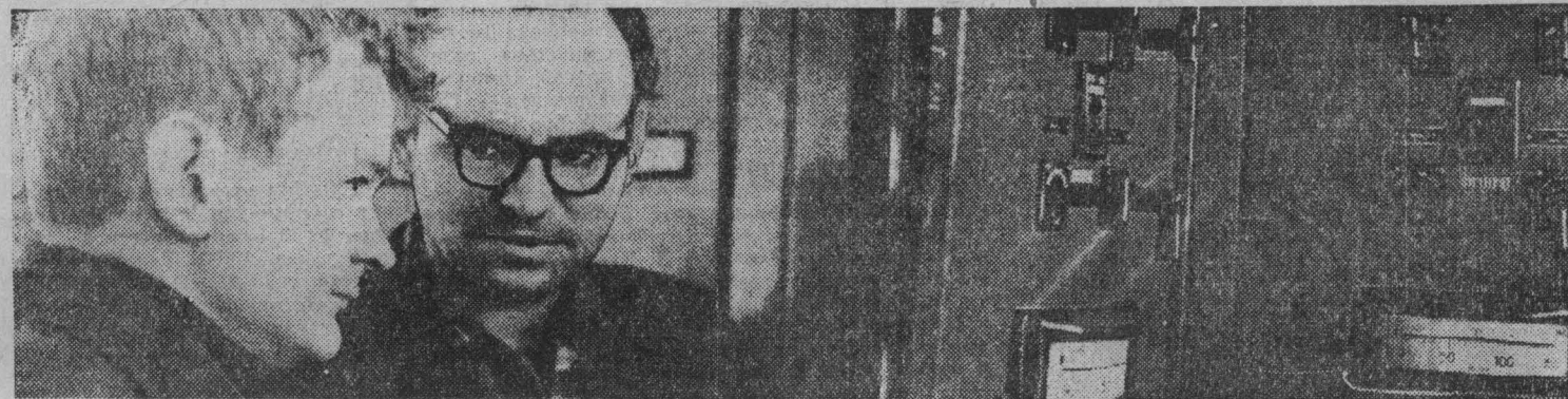
НА СНИМКАХ: (вверху) монтажники ленинск-кузнецкого ШМУ № 2 Василий ГОЛУБКОВ (слева) и Эдуард БРОЦМАН; (внизу) монтажник Анатолий МАЛЫШЕВ и инженер гидроузла Иван ГАТИЛОВ (справа) за регулировкой управления насосной станции.
