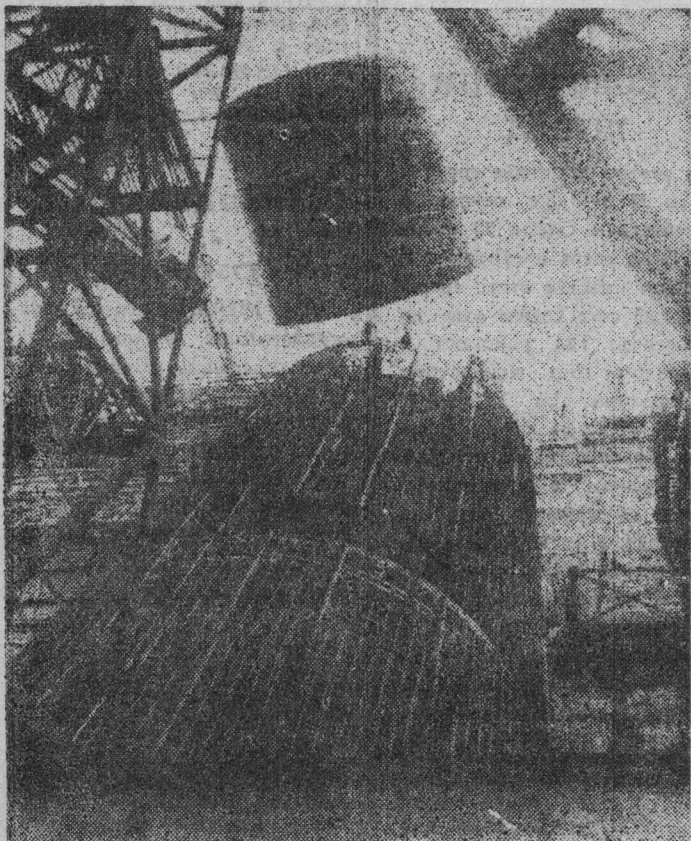
Полным ходом идет строительство ГЭС в Дивных горах на Енисее.
