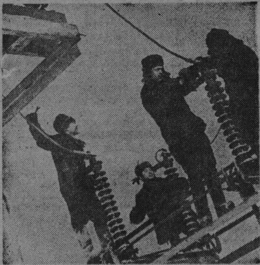
Сборка оборудования мощного энергетического узла — подстанции 220/110 квт во многом дело рук электромонтажников Кузбассэнерго Н. Г. Беленкова, Б. Ф. Горбачева, П. П. Червячука и Б. Н. Головных, которых вы видите на снимке. Сейчас они занимаются окончательной отладкой станции.
