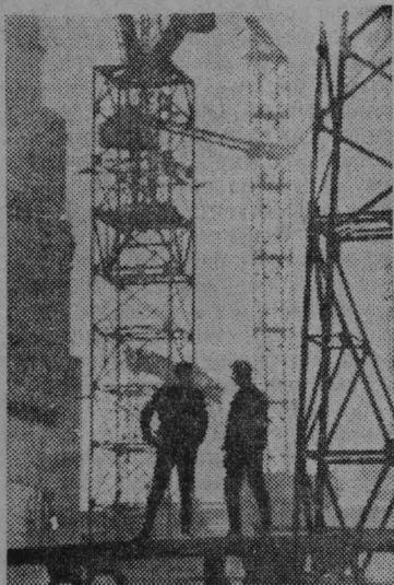
На Приднепровской ГРЭС наступил пусковой период. Уже закончен монтаж последнего, четырнадцатого энергоблока мощностью 300 тысяч киловатт. Энергетики и строители приступили к опробованию агрегата, регулируется сложная автоматика управления блоком. К празднику Великого Октября будет получен первый ток.
