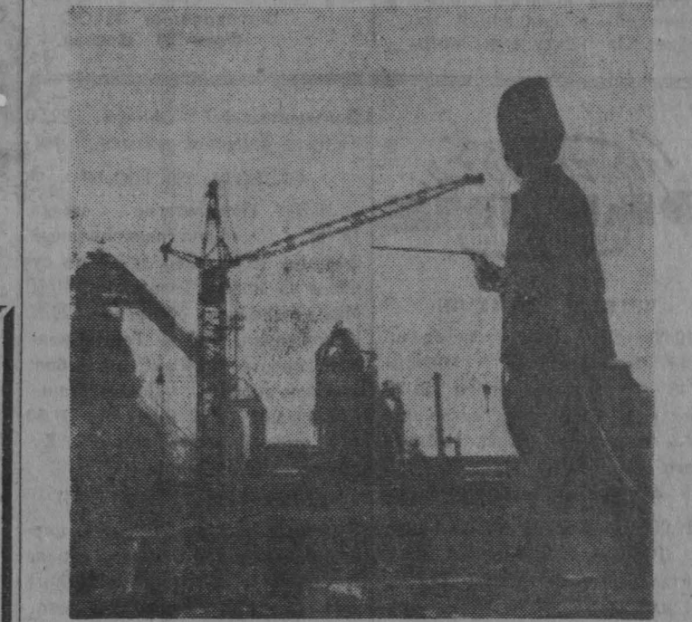
НА СНИМКЕ: на строительстве домны-гиганта. На переднем плане — сварщик Алексей Григоренко. Фото А. Запары. Фотохроника ТАСС.
