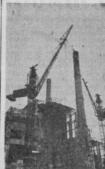
Строители Беловской ГРЭС накануне большого праздника. Скоро на Всесоюзной ударной комсомольской стройке вступит в строй действующих объектов второй блок — турбина мощностью в 200.000 киловатт и котел производительностью 640 тонн пара в час. По плану — это пусковой объект будущего года. Но энергостроители и монтажники решили сдать его досрочно, в декабре.
