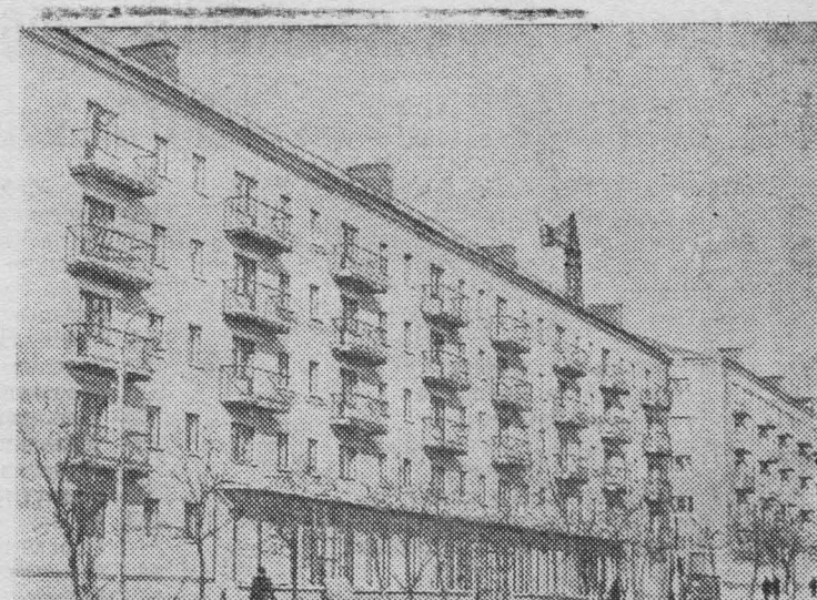
На одной из центральных улиц горняцкого города Шахты выросли новые пятиэтажные жилые дома. В них в ближайшее время отпразднуют новоселье 128 семей работников комбината «Ростов-уголь».
