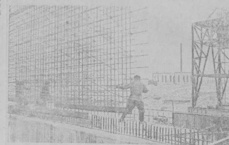
На строительстве Воронежской атомной электростанции закончен монтаж каркаса машинного зала, забетонирован фундамент турбогенератора № 1, подходит к концу монтаж сборных секций сбросного канала, завершены все работы по прокладке циркуляционного трубопровода. В помещении реакторного отделения уложено около 25 тысяч кубических метров бетона.
