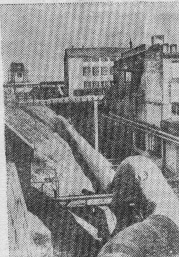
Чехословацкая Социалистическая Республика. В Южной Чехии находятся самые крупные залежи инфузорной земли. Эта земля очень пориста и является хорошим изолирующим материалом. Здесь построен завод «Калофриг», на котором изготавливаются высококачественные изоляционные облицовочные плиты, панели для строительства жилых домов.
