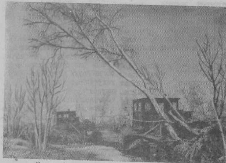
Здесь будет дорога.
