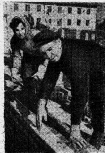
Лабаровск. Мастер строуправления № 271 Алексей Иванович Ходько возглавил отстающую комплексную бригаду, занятую на возведении жилого дома для рабочих завода «Амуркабель». Прошло три месяца, и бригада стала перевыполнять задания. План сентября выполнен на 130 процентов. Улучшилось качество работы, повысились заработки. На снимке: А. И. Ходько и молодая каменщица Людмила Колодина.
