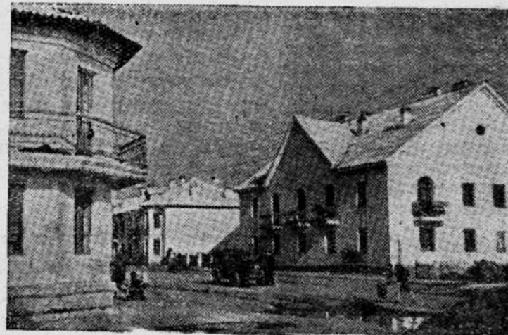
С каждым годом растет горняцкий поселок шахты «Шушталепская-1». В минувшем году здесь построен клуб, школа, детские ясли. Сейчас на территории постоянного поселка воздвигаются поликлиника и больница. Десятки новых жилых, хорошо благоустроенных и оборудованных домов построены за последние годы. Широкий фронт идет строительство жилья для угольщиков в этом году. На снимке: одна из новых улиц поселка шахты «Шушталепская-1».
