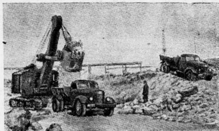
Казань. С наступлением теплых весенних дней развернулись работы на строительстве Казанского речного порта. В этом году коллектив строителей закончит разработку акватории (водной части порта) и сооружение металлической причальной стенки. На снимке: выемка грунта в акватории будущего порта.
