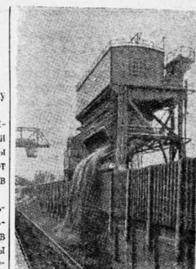
**Запорожская область.** На заводе «Запорожсталь» сдан в эксплуатацию вагонопрокладыватель, сконструированный и изготовленный Южно-Уральским заводом тяжелого машиностроения. Агрегат предназначен для разгрузки вагонов с шахтными материалами. С его помощью каждые две с половиной минуты разгружаются вагон весом в 60 тонн. Вагонопрокладыватель обслуживает три человека.
