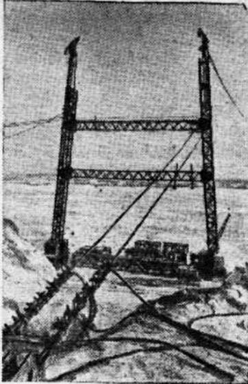
Сталинградгидрострой. В районе строительства Сталинградской ГЭС сооружается подвесная канатная дорога, по которой будут подаваться щебень, камень и песок для бетонных заводов и в котлован основных гидроэнергетических сооружений. На берегах Волги устанавливаются металлоконструкции опор подвесной дороги; их высота 132 метра.
