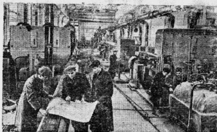
Алтайский край. На заводе «Алтайсельмаш» заканчивается монтаж автоматических линий, на которых будут изготавливаться лемеха и отвалы к плугам. Две линии будут выпускать 2.200 тысяч лемехов и одна линия — 600 тысяч отвалов в год. На снимке: монтаж оборудования автоматической линии.
