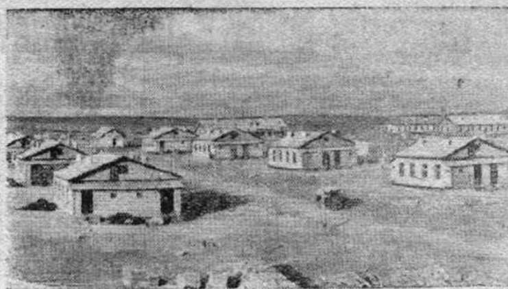
Казахстанская область. В совхозе «Тракторист», созданном на целинных землях, отстроена центральная усадьба. Более 80 семей механизаторов получили благоустроенные квартиры. Заключается строительство столовой, магазина и производственных предприятий. Осенью механизаторы решили заложить фруктовый сад и озеленить поселок.
