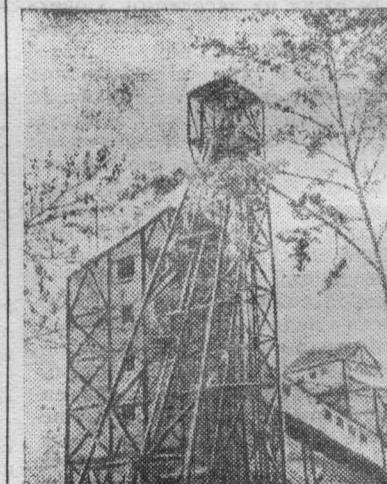
Заканчивается строительство одной из крупнейших в Тульском угольном бассейне шахты № 9 «Скуратовская». Все процессы, начиная от зарубки угля и до погрузки его в железнодорожные вагоны механизируются. На шахте будут работать угольные комбайны, врубовые и погрузочные машины, электровозы. Вводится дистанционное управление главными механизмами: из одного пункта один диспетчер сможет осуществлять управление транспортерами в штреках и лавах. В ближайшее время новая шахта даст первый уголь.
