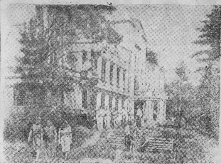
Кемеровская область. Близ города Прокопьевска в новом бору находится дом отдыха шахтеров, рассчитанный на обслуживание в течение года 2.500 человек. На снимке: главный корпус дома отдыха.
