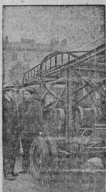
Группой инженеров Всесоюзного научно-исследовательского геологоразведочного института под руководством инженера И. А. Уткина сконструирован и изготовлен новый буровой станок «ГБГ-50», заменивший ручное бурение скважин.
