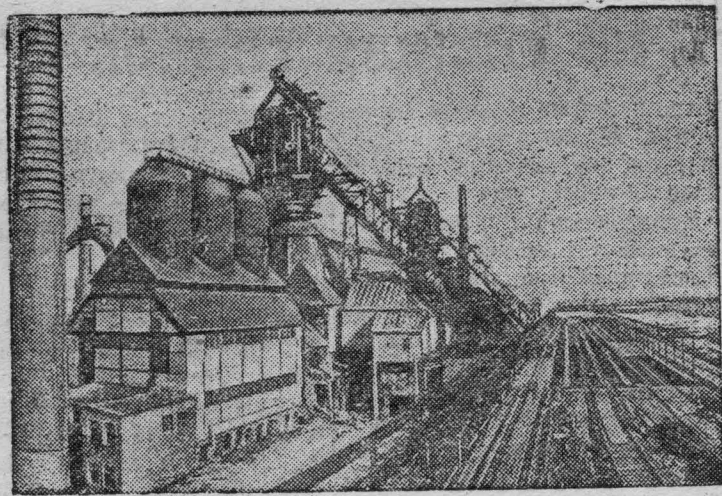
Строительство домен Ново-Тагильского металлургического завода.
