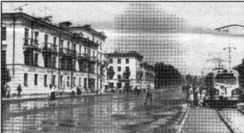
В строительство этих и многих других зданий города внесли свой вклад и работники осинниковского кирпичного завода.
