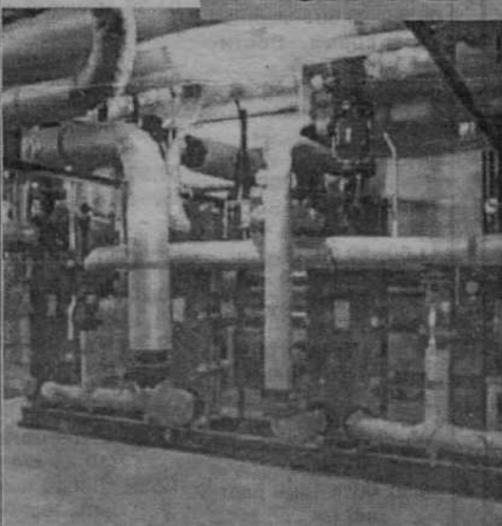
На эти средства будет приобретено следующее оборудование: пластинчатые теплообменники и насосные агрегаты. ООО «Теплоэнерго» проводит планомерную работу по замене громоздких и морально устаревших кожухотрубных теплообменников на современные, малогабаритные и легкие в обслуживании пластинчатые. В этом году на ЦТП будет установлено 6 таких теплообменников.
