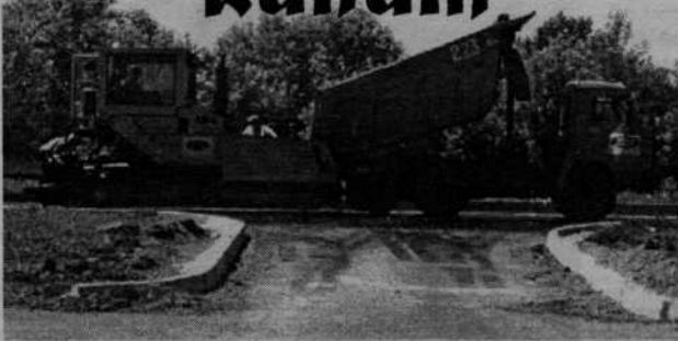
Ремонтные работы по ул. Революции идут полным ходом. Недавно произошедшая авария канализации на участке дороги рядом с трамвайной остановкой уже полностью устранена. На данный момент в самом начале улицы произведена установка новых бордюр, активно ведутся асфальтные работы. Недавно на этом отрезке улицы былложен последний слой асфальта. Теперь в планах рабочих продвигаться дальше, по направлению к перекрестку.
