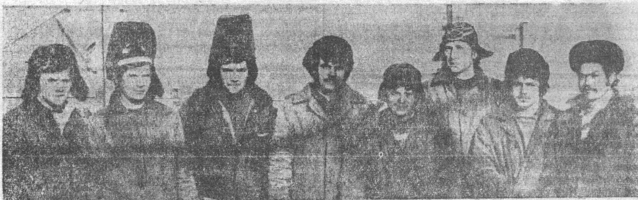
Бригада А. Н. Георгиева с четвертого участка Мысковского монтажного управления сейчас работает на монтаже теплоснабжения и сантехсистем теплиц строящегося осинниковского тепличного комбината. Это лучшая бригада в управлении. Она регулярно выполняет план на 130—140 процентов.
