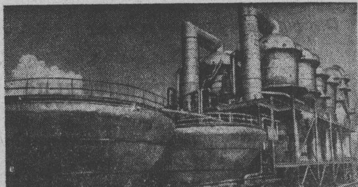
Казахская ССР. На побережье Каспия, в нескольких километрах от города Шевченко, сооружена атомная электростанция двойного назначения с реактором на быстрых нейтронах БН-350. Ее электрическая мощность — 150 тысяч киловатт, и одновременно за счет тепла, выделяющегося в ходе цепной реакции деления урана, можно получить 120 тысяч тонн опресненной воды в сутки.
