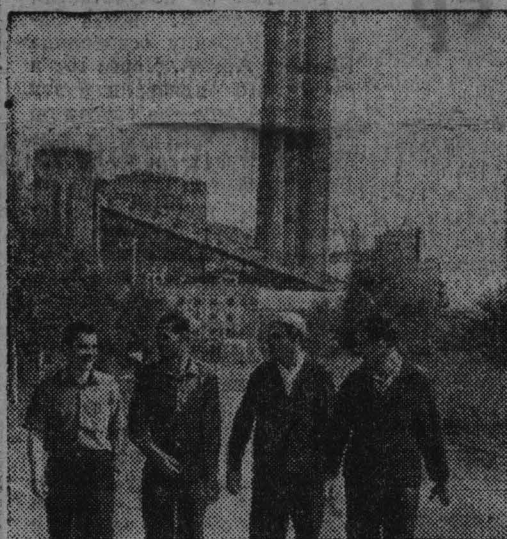
Красноярск и край. На седьмом агрегате Назаровской ГРЭС ведутся пусконаладочные работы. Здесь проводятся испытания многочисленных узлов теплового турбогенератора.
