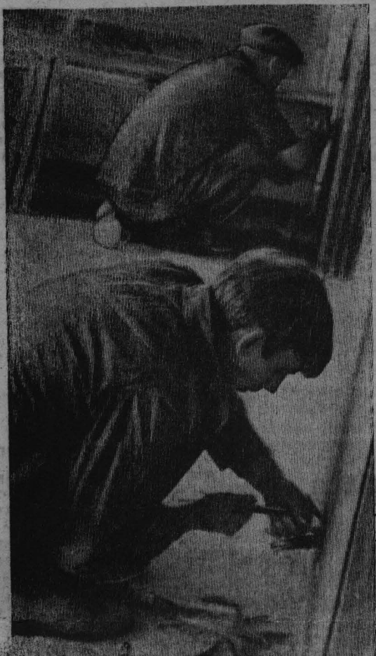
Магазин «Юбилейный», который скоро откроется на улице «Победа», — продовольственный. Он рассчитан на 26 рабочих мест. Все трудоемкие процессы в нем механизированы. Установлена мощная холодильная аппаратура. А сейчас в магазине идет монтаж другого оборудования.
