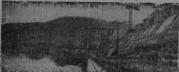
ДИВНОГОРСК. Панорама строительства Гусинской ГЭС и нижнего бьефа.
