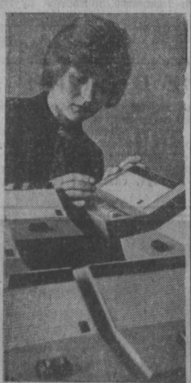
Литовская ССР. Помощники в управлении производством станут новые транспортные аппараты «Гарсас-10», массовый выпуск которых начал Паневежский электротехнический завод. Они предназначены для оперативных переговоров. Руководитель предприятия, имея у себя аппарат, может нажимать кнопки и участвовать в разговоре. Фото А. Дилиса. Фотохроника ТАСС
