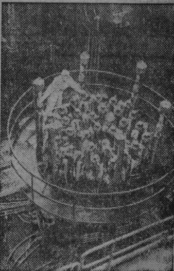
Реактор Нововоронежской атомной электростанции. Снимки Фотохроники ТАСС
