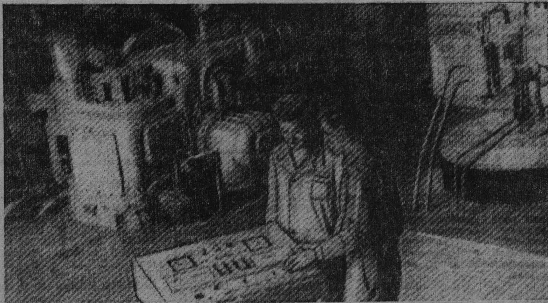
На снимках: старший инженер треста «Ростов-энергоремонт» А. Добряков и наладчик цеха КИП ЮК ГРЭС Л. Волков у пульта управления автоматического пуска турбин.
