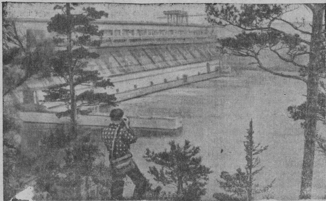
Вид крупнейшей в мире Братской ГЭС.
