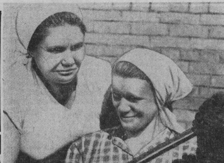
В комплексной бригаде коммунистического труда т. Германа (СУ-6) славно трудятся подсобные рабочие Е. М. Зенкова, Е. И. Вергун. Они своевременно и качественно готовят раствор, что позволяет каменщикам быстро вести кладочные работы, перевыполнять нормы выработки. На снимке: передовые производственницы Е. М. Зенкова, Е. И. Вергун.
