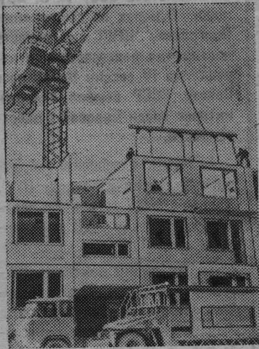
Ленинград. Монтаж нового благоустроенного жилого дома.
