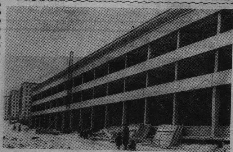
Москва. На Ломоносовском проспекте столицы строится здание крупнейшей в мире аптеки. Здесь в специальных лабораториях будут испытываться новые виды лекарственных средств. В лекционных залах крупнейшие специалисты будут выступать с лекциями перед фармацевтическими работниками. В первом этаже здания разместится торговый зал, оборудованный по последнему слову техники. Здание аптеки строится из сборного железобетона по проекту коллектива мастеровской № 10 института «Моспроект».
