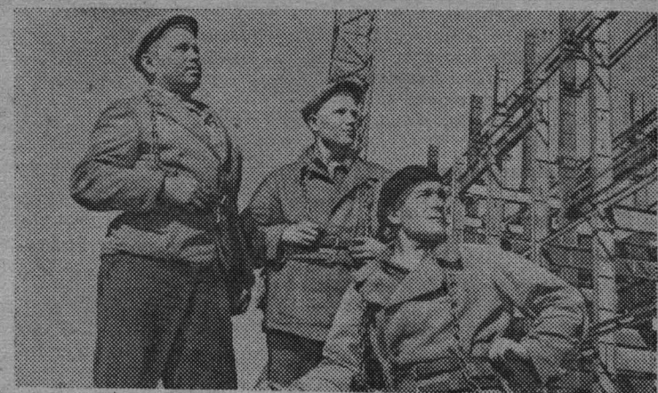
КАЗАХСТАН. Монтажные-верхолазы — люди трудной и смелой профессии. Ни холодный ветер, ни высота, от которой у обычного человека кружится голова, не страшат их. Эти огромные многотонные стальные каркасы будущего гиганта большой химии — Чимкентского завода фосфорных солей возведены ими. Комсомольско-молодежная бригада Василия Емцева — одна из лучших на стройке. Ее коллектив систематически перевыполняет задания, славится хорошим качеством монтажных работ.
