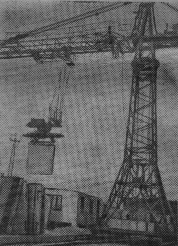
Группа изобретателей экспериментальной мастерской Волгоградского треста «Оргстрой» разработала способ монтажа зданий или сооружений из крупноразмерных элементов с помощью крана-автомата.
