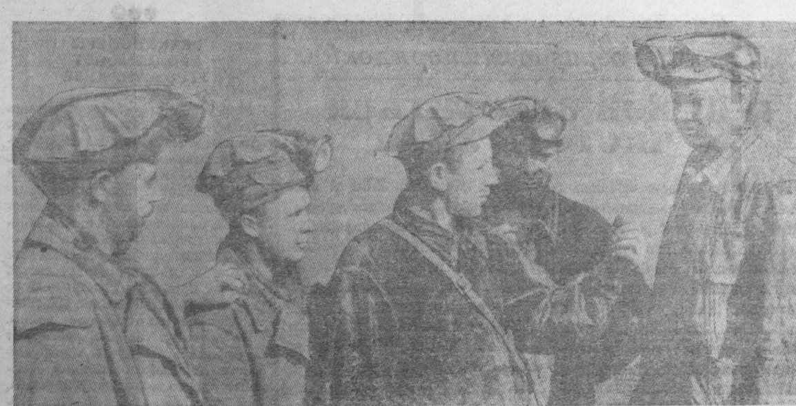
На строительстве шахты «Аларинская-1» отличается в труде звание проходчиков Василия Яковлевича Тыршккина. Работая в трудных условиях, он успешно справляется с поставленной задачей.
