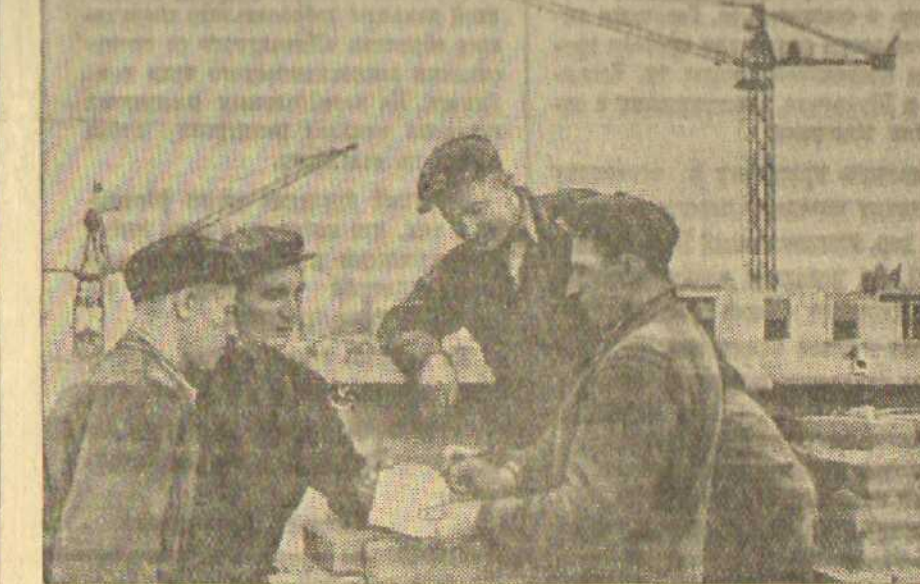
С большим успехом прошла подписка на новый Государственный заем развития народного хозяйства СССР в стройуправлении № 4 треста «Сталинскпромстрой». На снимке: монтажник А. А. Апраксин подписывается на новый заем.
