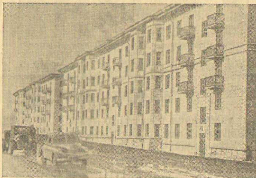
Коллектив стройуправления № 1 треста «Сталинскпромстрой» в предмайском соревновании взял обязательство сдать в эксплуатацию жилой дом № 6 по проспекту им. Курако. Сейчас здесь полным ходом ведутся отделочные работы. На снимке: фасад многоквартирного жилого дома № 6 по проспекту им. Курако, подготовляемый к сдаче в эксплуатацию.
