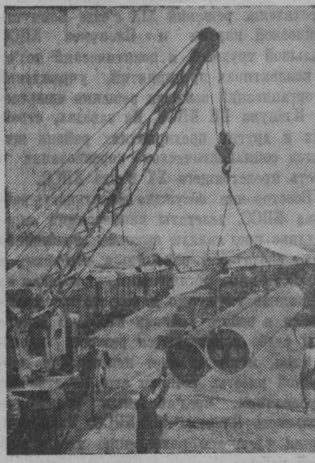
Строители газопровода Ставрополь—Москва, соревнуясь в честь XX съезда КПСС, добились крупной производственной победы. Они досрочно закончили сварку труб на трассе первой очереди Ставрополь—Ростов-на-Дону.
