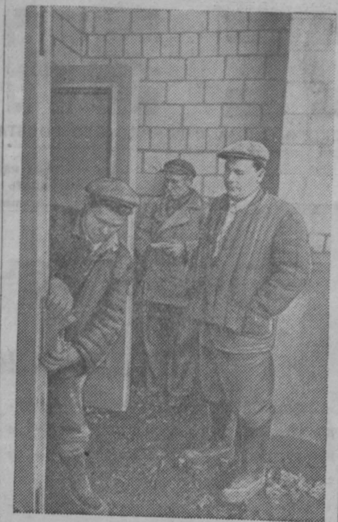
На строительстве 726-квартирного дома на юго-западе Москвы. На снимке: бригадир столбров Ф. И. Горнов (в центре) и его ученик И. Молчанов. Справа — начальник строительства М. В. Титаринцев. Фото А. Сухомлинова.
