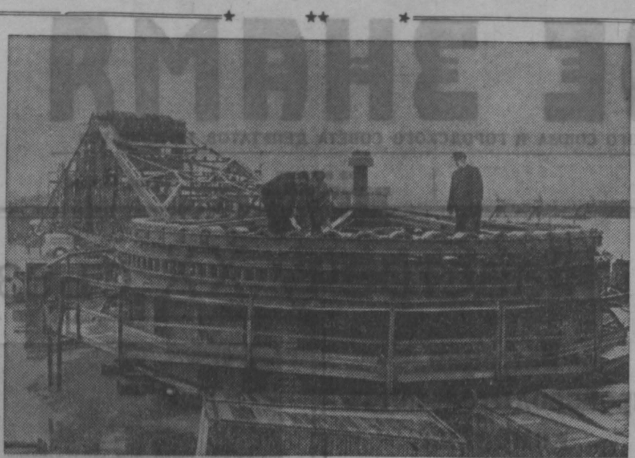
Ленинград. Судоремонтный завод треста «Балтфлот» спустил на воду пловучий самоходный кран грузоподъемностью в 50 тонн. Длина его 40 метров, ширина — 20 метров, общий вес — около 1.500 тонн. Сейчас слесари-монтажники приступили к сборке металлоконструкций и механизмов крана. Ввод его в действие обеспечит механизацию трудоемких работ в гидротехническом строительстве и на ремонте судов технического флота.
