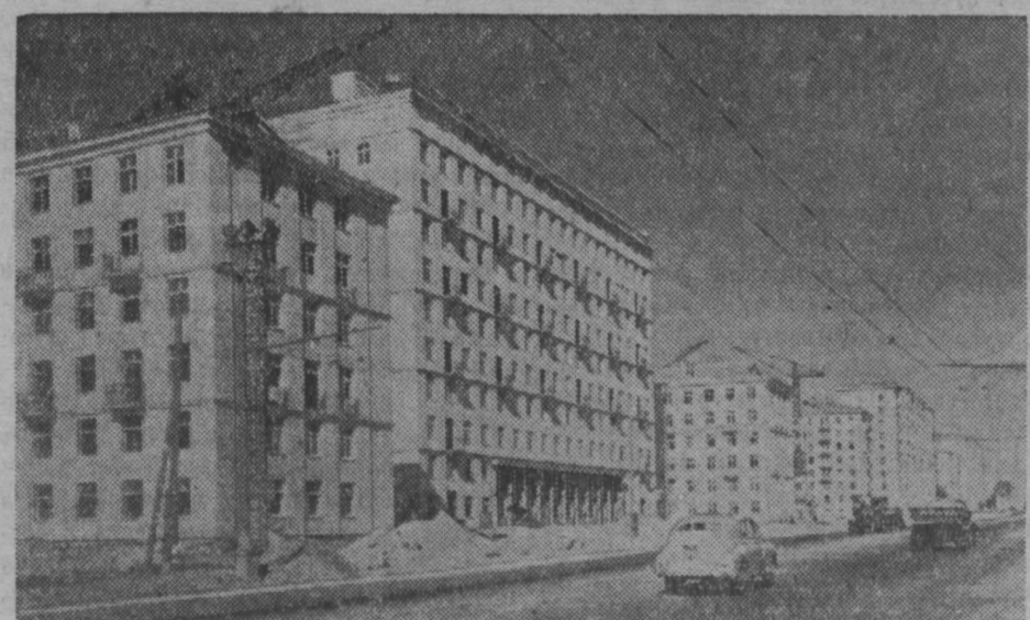
Москва сегодня. Строительство каркасно-панельных жилых домов на 1-й Хорошевской улице. Фото Н. Грановского.
