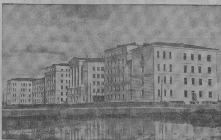
Коллектив строительного управления № 1 треста «Сталинскпромстрой» заканчивает отделку терапевтического корпуса городской больницы, который будет сдан в эксплуатацию в ближайшие месяцы. Сейчас здесь идет установка оборудования и мебели.
